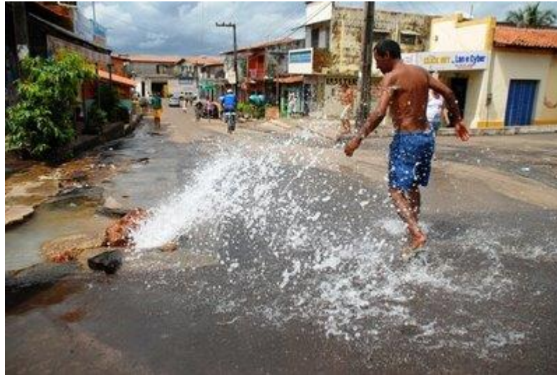
Figura 1 - Vazamento de água causado pelo rompimento de um cano subterrâneo na cidade de Salvador-BA
